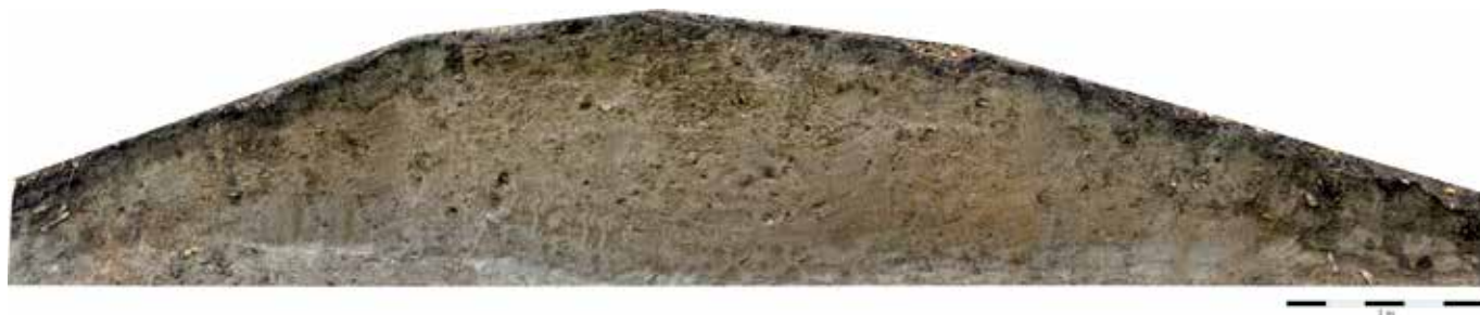
Ryc. 17. Dubia, st. 1. Przekrój przez wał w południowej części grodziska (fot. B. Klęczar, oprac. M. Rutyna)
